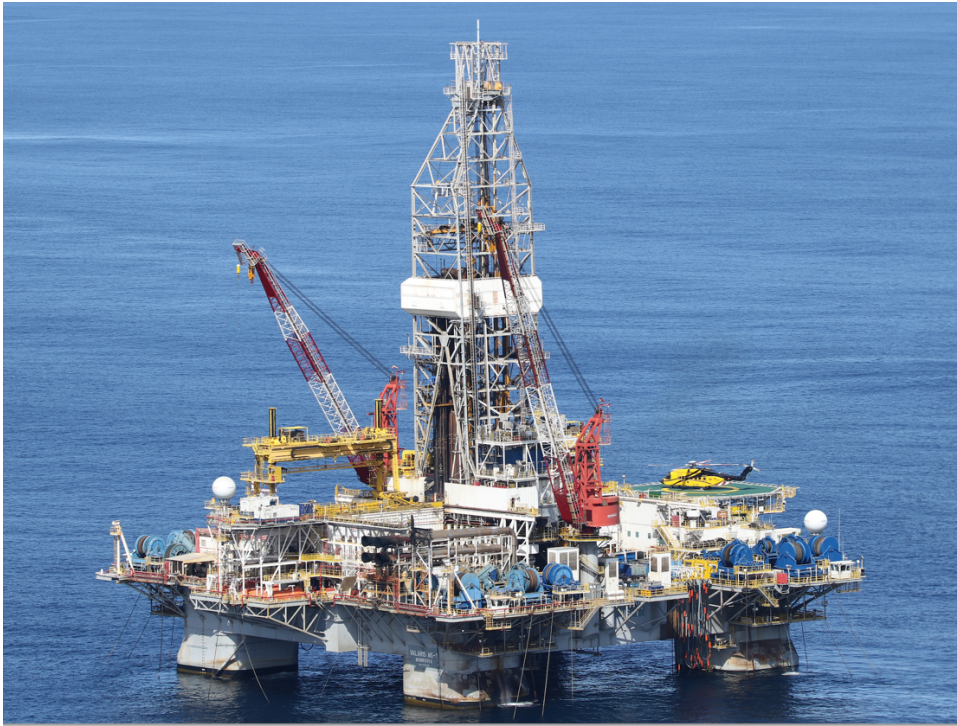
Valaris MS-1 drill rig.
